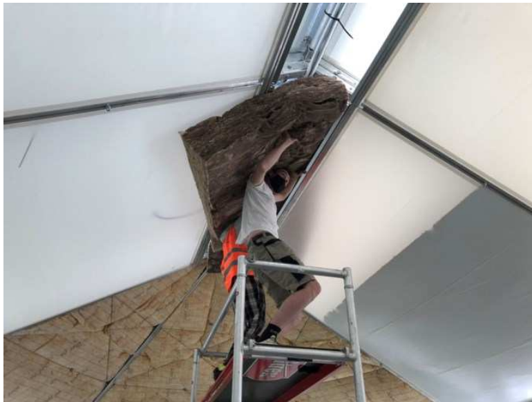
Er wordt hard gewerkt aan de opbouw van de Maggie-tenten. FOTO: MDT
